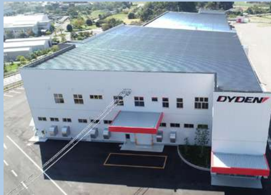
最先端の中原工場
