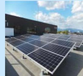
屋上緑化に代わる環境配慮設備として、本社屋上に太陽光発電設備を設置しました。太陽光発電によってつくられた電力は、本社ビルの照明や空調機の電源として活用しています。また本社玄関前には発電量がリアルタイムで表示されるモニターも設置しました。
