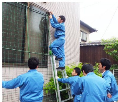
緑のカーテン設置作業の様子
